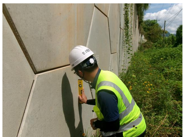
경사계를 이용한 경사도 측정
